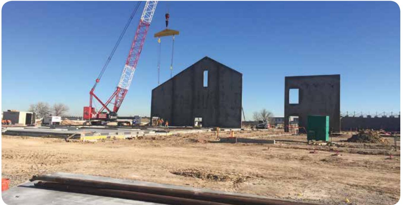
“Los operarios elevan la primera de muchas paredes ed concreto que ahora ya se ven en la esquina de E. 112th Avenue y Potomac Street.”
